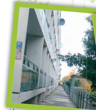
Altangang, boligblok, Bentesvej
